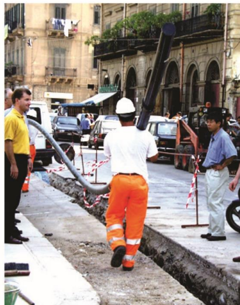
Narrow Trenching using PE pipes
