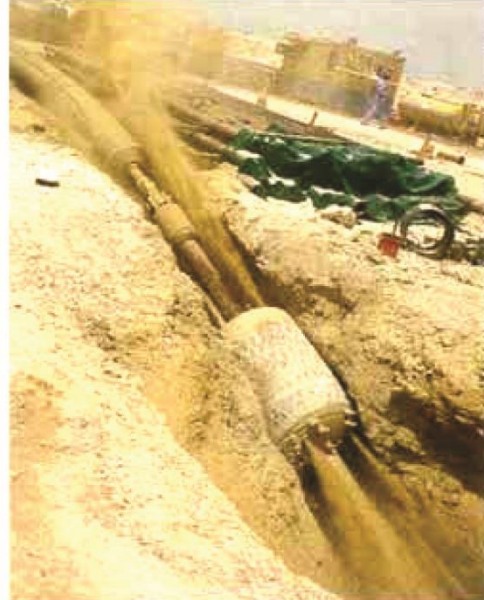
Microtunnelling using PE pipes
